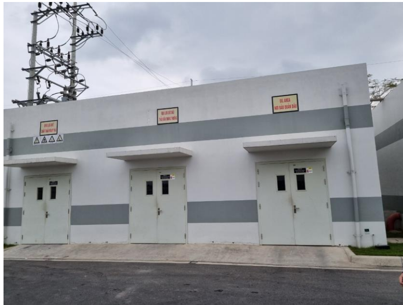
Hình 3. 14. Kho chứa rác thải sinh hoạt, kho chứa rác thải công nghiệp thông thường và kho chứa CTNH của nhà máy
