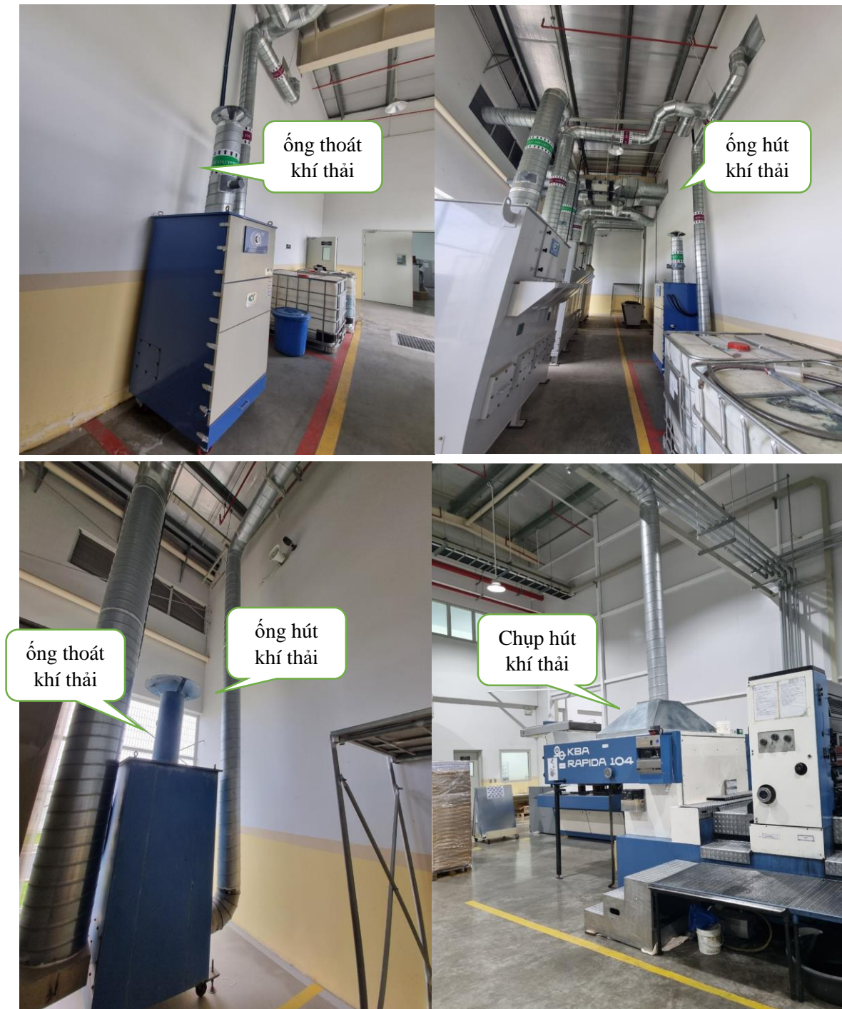
Hình 3. 10. HTXL bụi từ công đoạn phun bột lên bề mặt vật liệu trong quá trình in Offset
