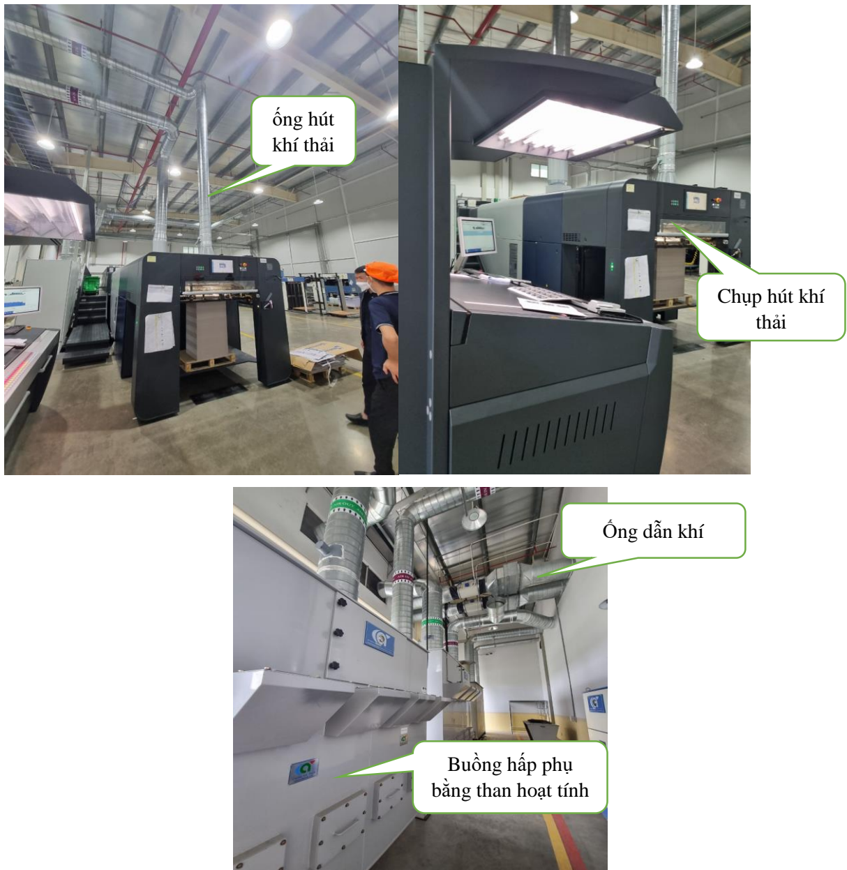
Hình 3.12. HTXL khí thải từ công đoạn in, cán phủ, dán keo, rửa lô mực, làm hiện bản in và vệ sinh bản in của máy in Offset
