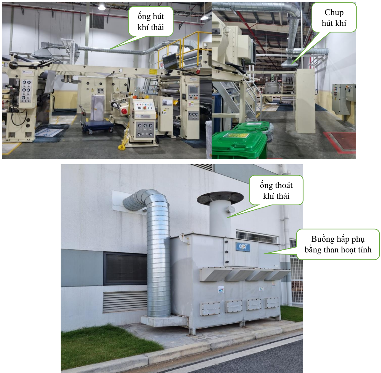
Hình 3. 13. HTXL khí thải từ công đoạn in, cán phủ, dán keo, rửa lô mực, làm hiện bản in và vệ sinh bản in của máy in Gravure
