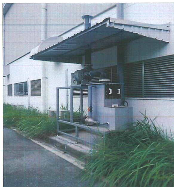
Hình 3- 12: Hình ảnh hệ thống thu gom và xử lý khí thải phòng thử nghiệm
