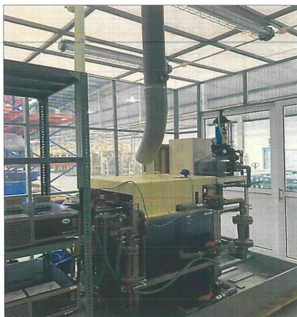
Hình 3- 12: Hình ảnh hệ thống thu gom và xử lý khí thải phòng thử nghiệm
