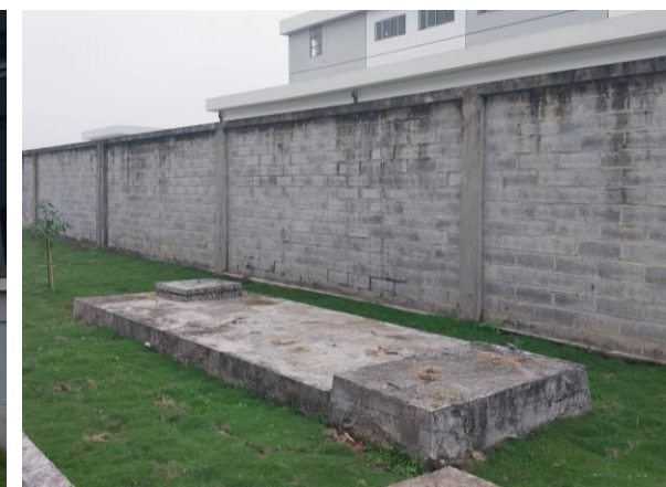
Hình 4: Hình ảnh khu vực bể lắng, lọc 4 ngăn của nhà máy
