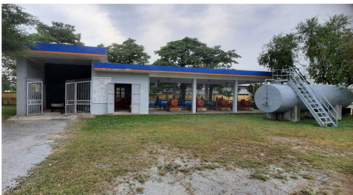
Hình 3.9. Ao chứa nước chữa cháy, đường ống chữa cháy, gara + nhà bơm nước chữa cháy
