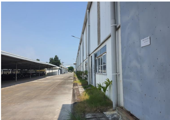
Hình 3.3. Hệ thống thoát nước mưa khu vực dự án
