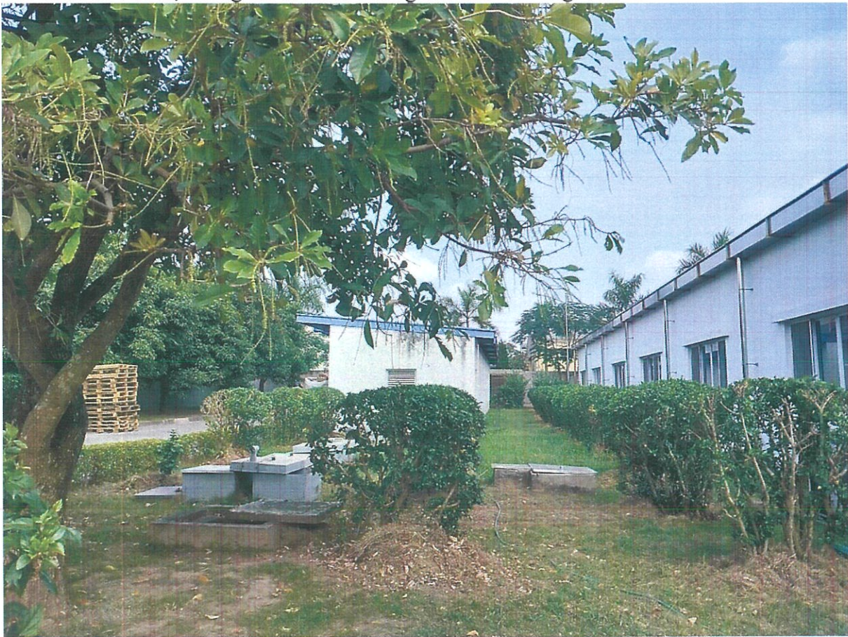
Hình 3-5: Hình ảnh hệ thống xử lý nước thải của nhà máy
