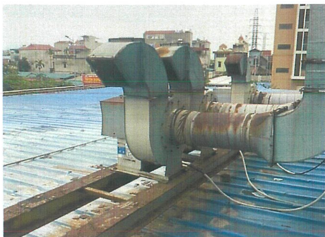
Hình 3- 7: Hình ảnh thực tế của điểm thoát khí thải khói hàn
