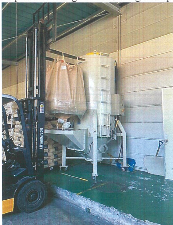
Hình 1-2: Hình ảnh máy sấy nhựa của nhà máy
