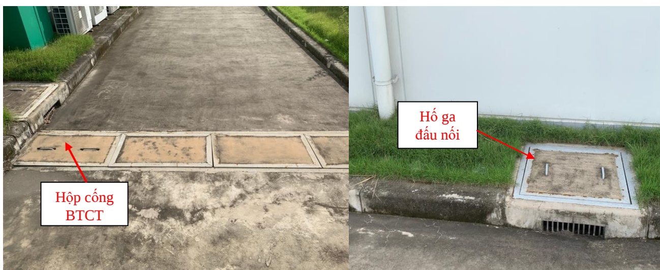
Hình 10: Hệ thống thoát nước mưa
