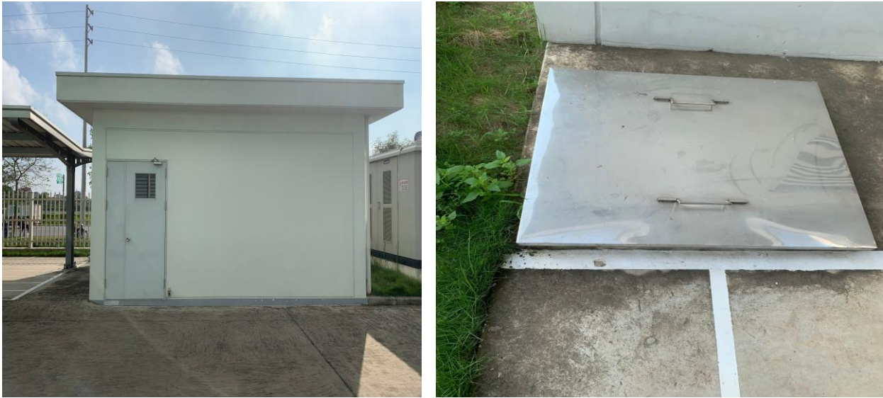
Hình 8: Nhà bơm và bể cấp nước cho dự án
