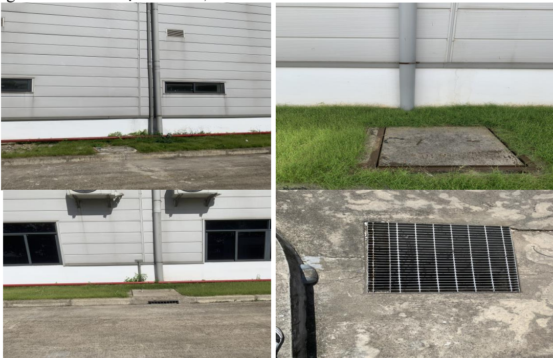
Hình 4. 4. Hệ thống thoát nước mưa trong khuôn viên của nhà máy Jochu
