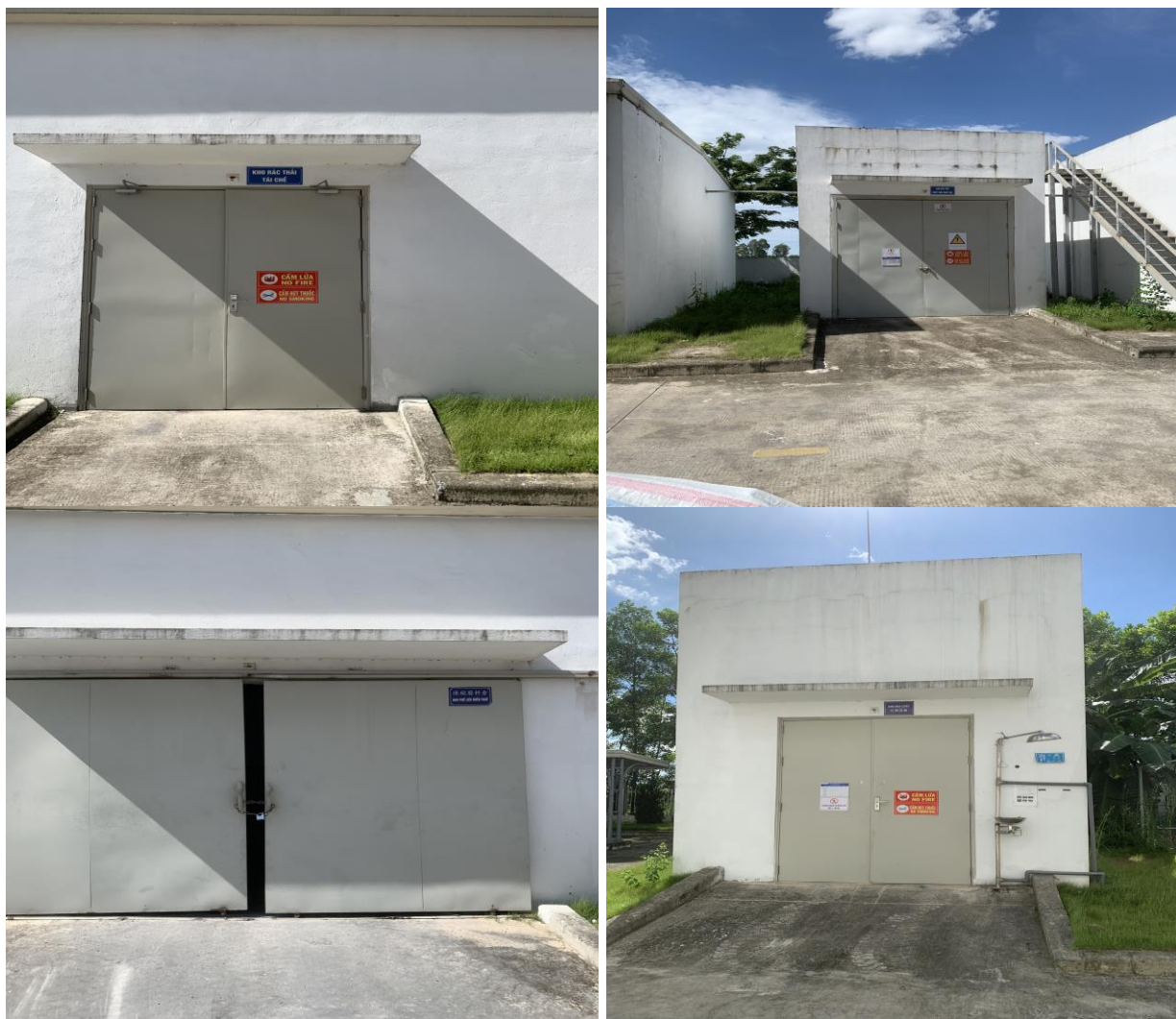
Hình 1. 22. Khu vực kho chứa của nhà máy
