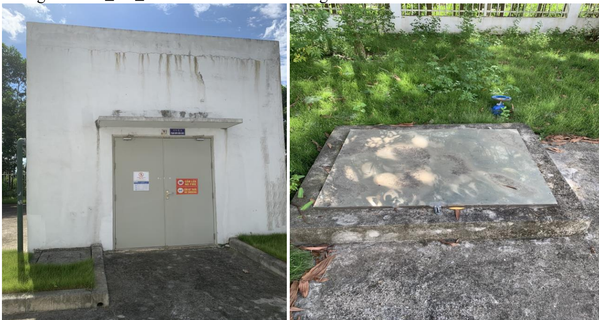
Hình 1. 19. Trạm bơm và bể nước của Nhà máy
