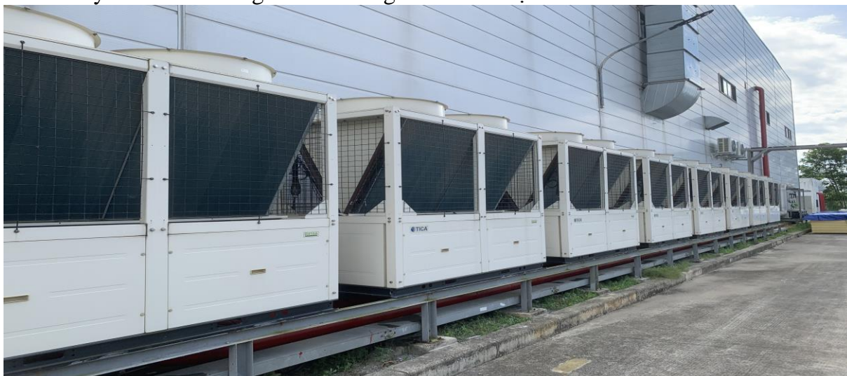
Hình 4. 2. Hệ thống quạt thông gió cấp khí tươi cho nhà xưởng
