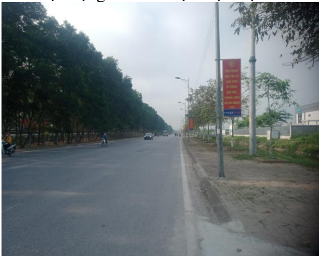
Tuyến đường nội bộ KCN giáp dự án
