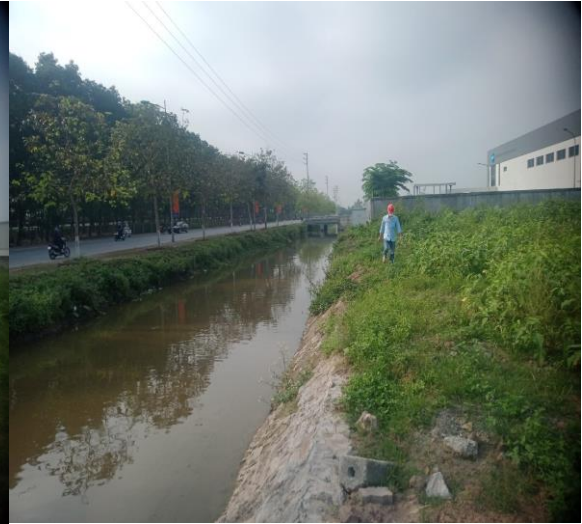
Mương thoát nước mưa KCN giáp DA
