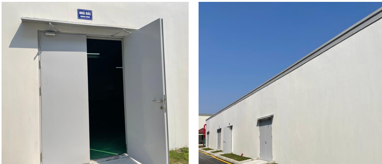
Hình 4. 22. Các kho chứa rác thải nhà máy
