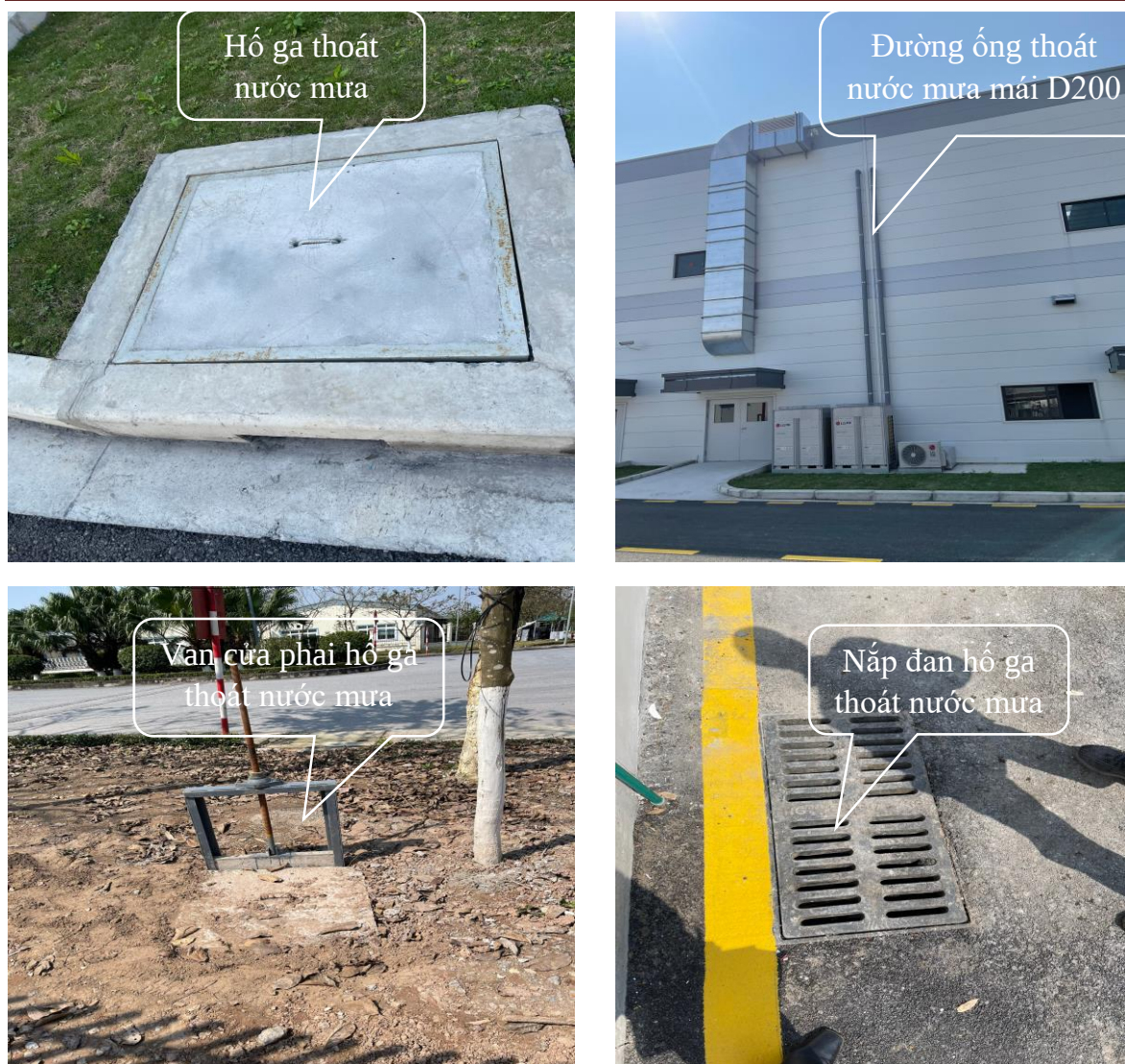
Hình 4. 11. Hệ thống thu gom, thoát nước đã được xây dựng của dự án
