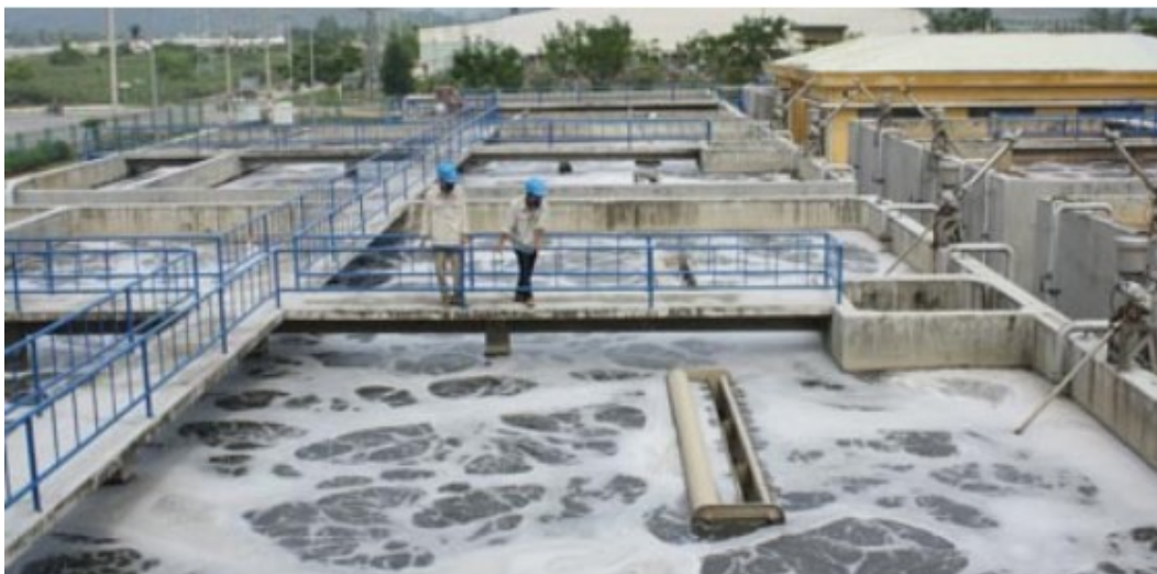
Trạm xử lý nước thải KCN Đồng Văn IV
