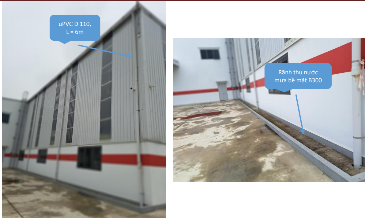
Hình 4.11. Hình ảnh hệ thống thu gom và thoát nước mưa tại nhà máy - Sơ đồ hệ thống thu, thoát nước mưa được thể hiện trong sơ đồ sau:
