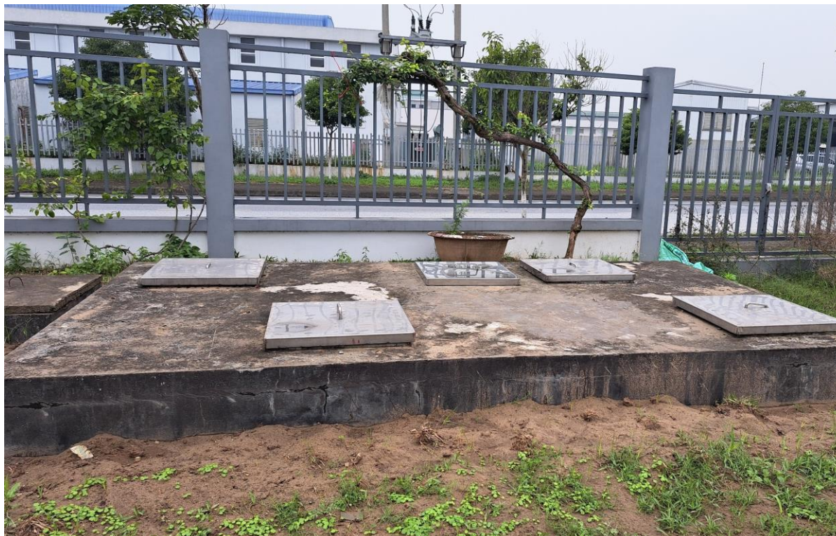
Hình 4.9. Hình ảnh trạm xử lý nước thải tại dự án
