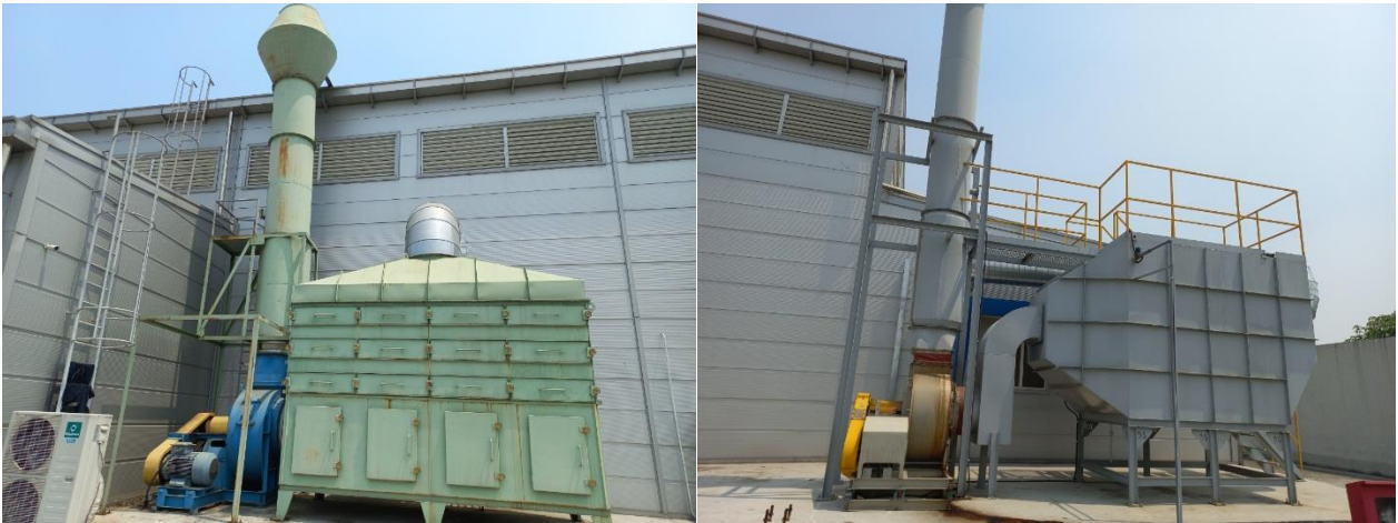
Hình 3.5. Hình ảnh hệ thống xử lý khí thải khu vực cán và khu vực đúc
