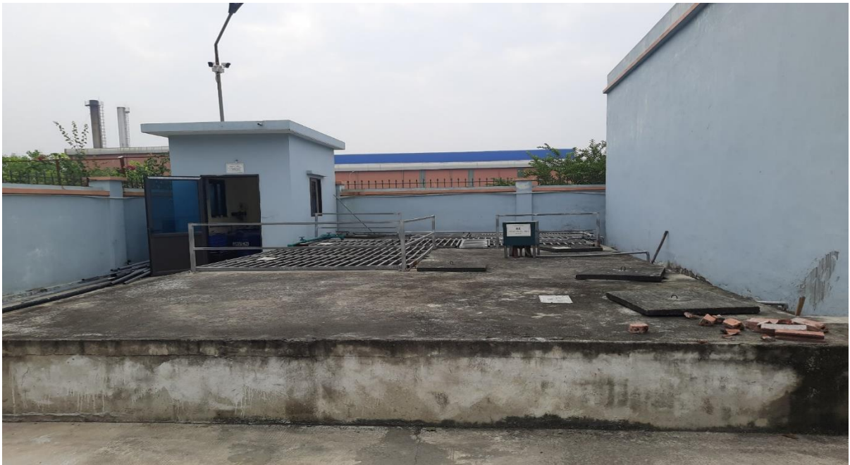
Hình 14. Hình ảnh thực tế hệ thống XLNT sinh hoạt 35 m 3 /ngày.đêm tại nhà máy
